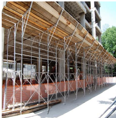
Figura 1 – Exemplo de Bandeja de Proteção montada sobre andaimes
